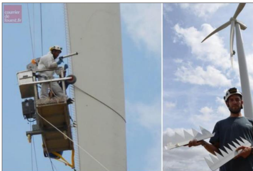
INSTALLATION DE SERRATIONS SUR LE PARC EOLIEN DE BORALEX DE COULONGES, LE COURRIER DE L'OUEST, 2016
